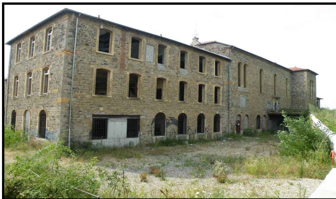
Côté droit du bâtiment avec sa chapelle à l'arrière.
